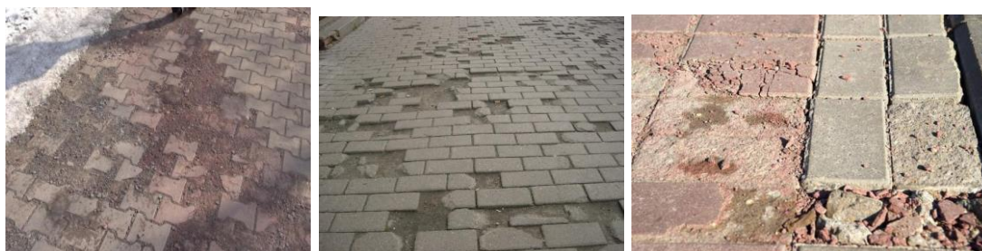
Сурет 23 - Бетон төсемдерінен жасалған жаяу жүргіншілер жолының бұзылу фрагменттері
