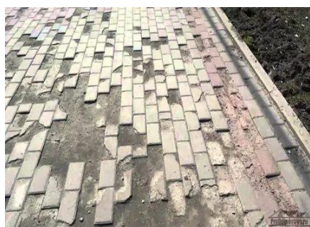
а) толық бұзылу; б) төсемдердің беттік қабатының бұзылуы
