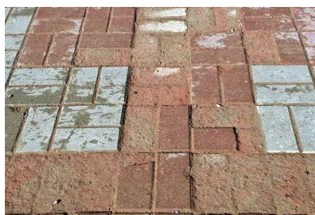
а) толық бұзылу; б) төсемдердің беттік қабатының бұзылуы
